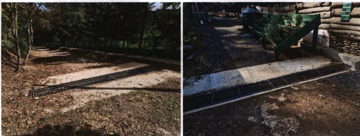
Foto 32-33: Zanja y pozo de absorción para conservación de suelo y manejo de agua pluvial en el mirador principal y granja educativa
